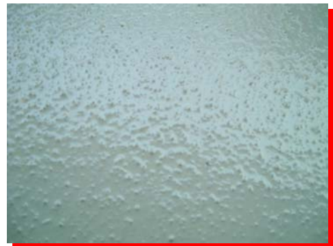
仕上げ状況:滑り止め仕様
